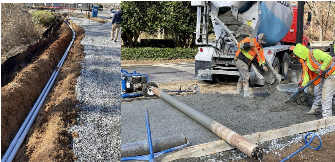
Trail 2A – Conduit Install and Pervious Test Pour
