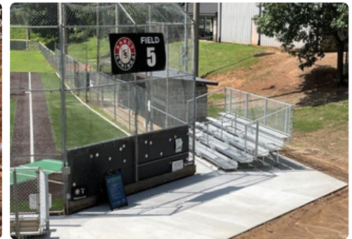
Morgan Falls Athletic Complex Field 5 Concrete Pour
