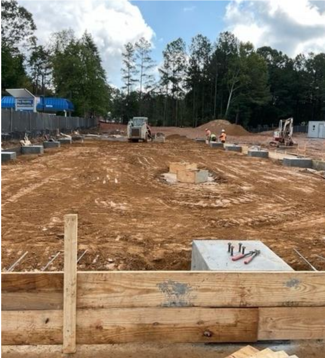
Prep Slab For Concrete Pour
