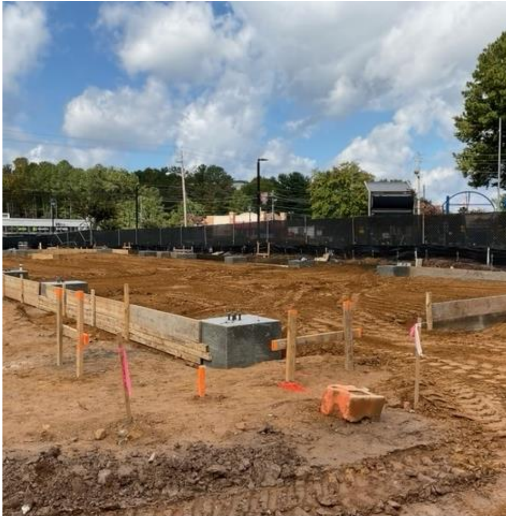
Prep Slab For Concrete Pour
