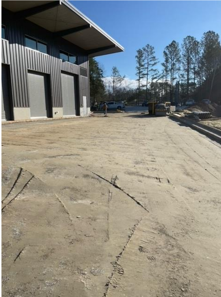
GAB Compacted - Prepping For Concrete Pour
