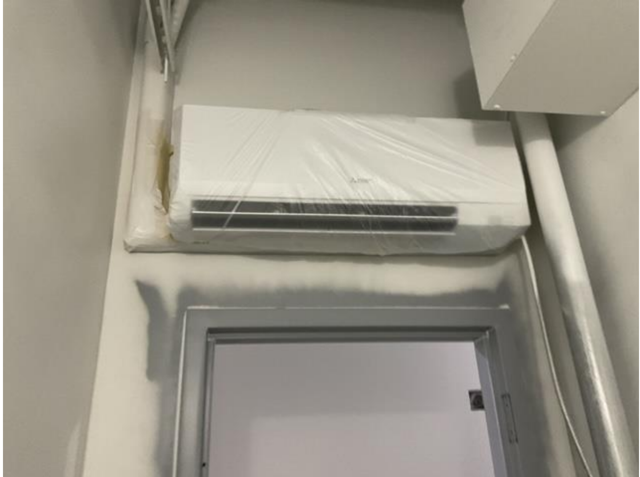
Mini Split Unit Install
